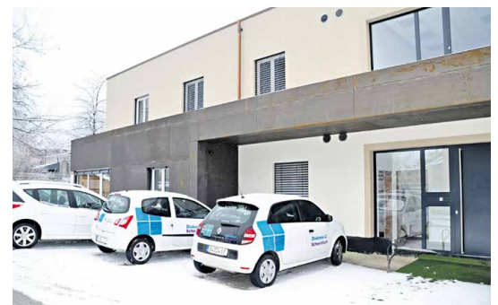
Neue Diakoniestation Schweinfurt-Stadt in der Niederwerrner Str. 22 1/2
